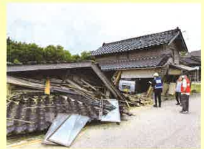
現地調査風景
